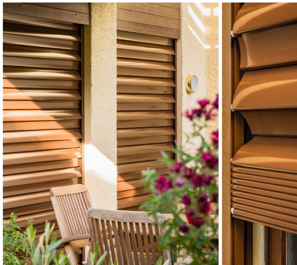
MEHRFAMILIENHAUS, ST. GALLEN
